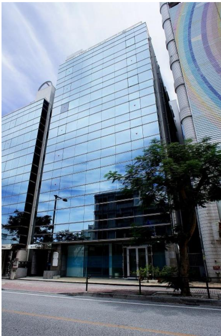
フェアビル外観
